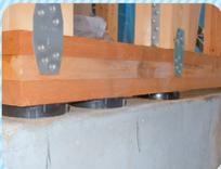
基礎と土台の間に基礎パッキンを設置。こうすることで床下と外部の換気を可能にし、通気性のある床下環境づくりにつなげています。
