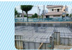
太さ13mmの鉄筋を200mm間隔で碁盤目状に配筋した上にコンクリートを流し込む「ベタ基礎」方式を採用。耐震性や不同沈下への耐久性に優れ、床下防湿対策にもなるのが特長です。
