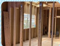
一建設では、住宅性能評価制度「構造の安定に関すること」における耐震等級で、最高等級(等級3)の基準にて耐力壁(耐力面材等)を設計しております。これは数百年に一度発生すると想定される大地震に対して、建物が倒壊・損傷しないようにすることです。
