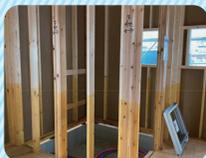
柱や壁面など床から約1mの範囲には白アリに対する防蟻効果の高い薬剤を塗布し、見えないところも手を抜かずに防蟻処理を施しています。
