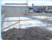
住宅の基礎となる部分を油圧ショベルで掘削して作るのが「根切り（ねぎり）」です。この後に碎石を敷きつめ、それを締め固め全面を防湿シートで覆い、最後に墨出しの基準となる捨てコンクリートの打設を行います。
