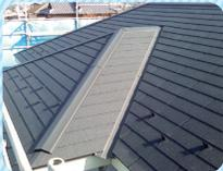
屋根には重さが陶器瓦の約1/2以下のスレートを採用。屋根を軽くすることで住宅の負担を少なくすることができ、耐久性が向上します。
